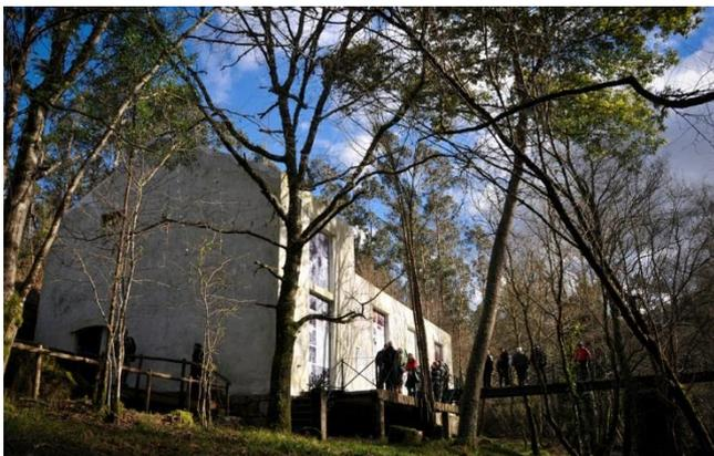
A Central Hidroelétrica em Covas está localizada na margem direita do rio Coura, tendo acesso através de um trilho pedestre e relaciona-se com a outra margem por pontão. Edifício construído em alvenaria de granito rebocada e pintada a branco, apresenta planta retangular
